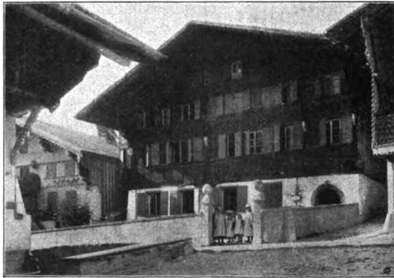
FIG. 244. — Chalet à Rougemont (S. M. H.).
